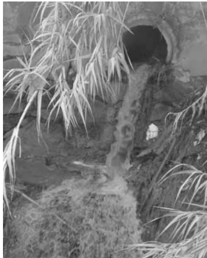
Figura 8. Descarga de aguas negras hacia la Barranca del río Santiago. Fuente: Anaya-Corona, M. (25 Julio 2009).
