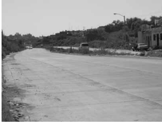
Figura 7. Avenida Malecón, entubamiento del río Osorio. Fuente: Anaya-Corona, M. (18 Julio 2009).
