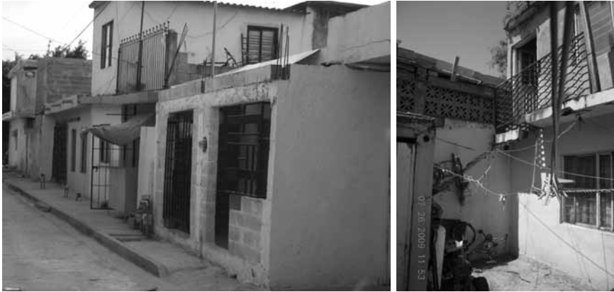
Figura 46. Problemas de autoconstrucción e "invasión" del espacio (de la calle y de los vecinos).
