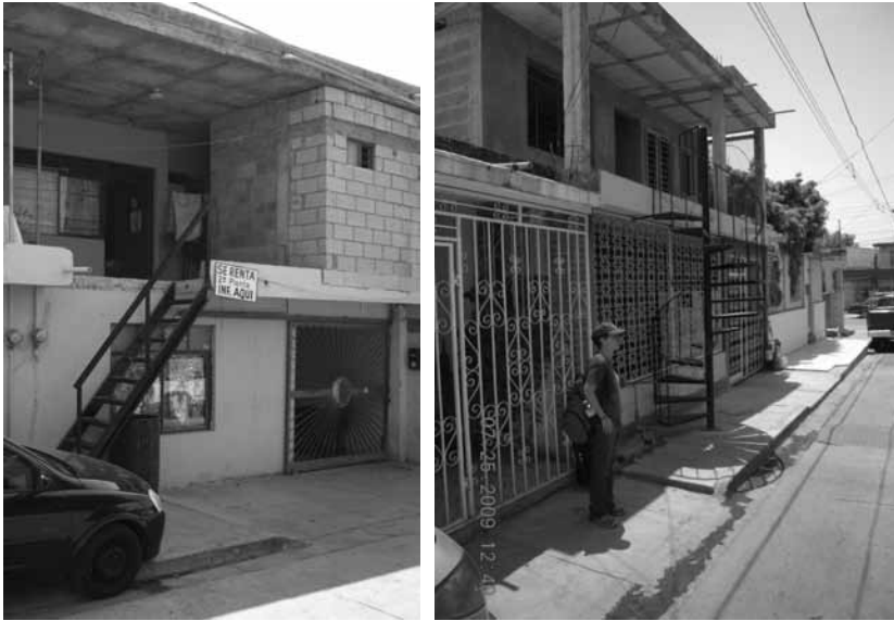
Figura 49. Escaleras al segundo piso en el espacio público.
