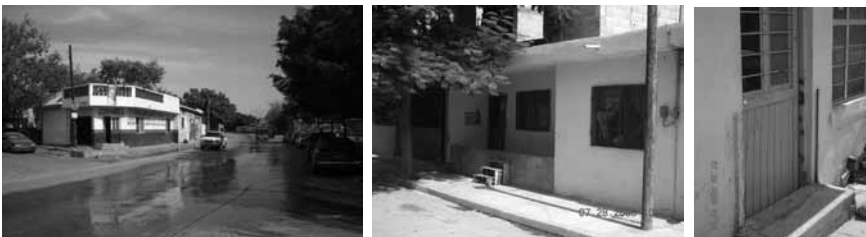
Figura 47. Inundaciones y maneras de evitar que entre a la casa: escalones y "compuerta".
