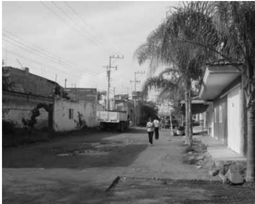
Figura 6. Banquetas con excesivos desniveles, Colonia Jalisco. Fuente: Anaya-Corona, M. (25 Agosto 2008).
